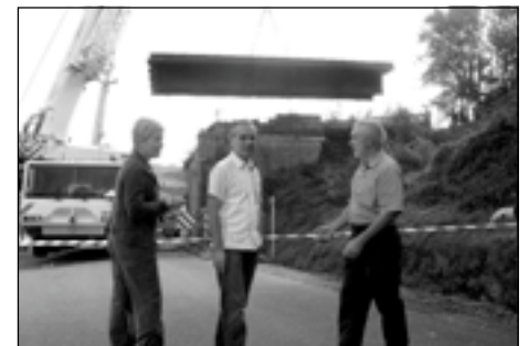
Soulevé avec précaution, le pont (17 tonnes) va être déposé, réhabilité, puis remis en place.
